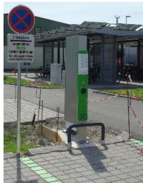
Errichtung Ladesäule am Bhf. Leibnitz
